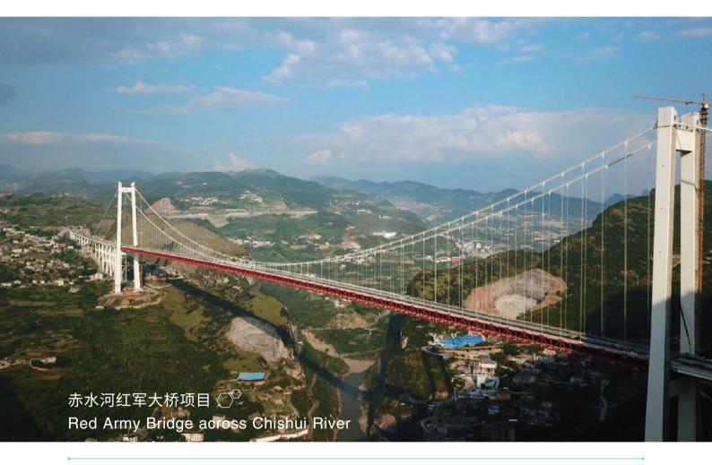
该项目位于川黔交界的乌蒙山区和中国工农红军"四渡赤水"的革命老区,是目前世界上山区同类型钢桁梁悬索桥梁中 第一高塔、第二大跨度的峡谷大桥,于2019年9月全面建成通车。项目通车后将进一步完善区域路网,有效降低区域物 流成本,增强川南、黔北、渝西等地的互联互通,深化地区分工协作,促进区域经济发展,有力带动红色旅游扶贫产 业,为打赢乌蒙连片山区深度扶贫攻坚战注入强心剂。
